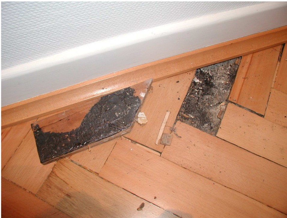
Bild 1: PAK-haltiger Teerkleber unter einem alten Parkettboden (Fallbeispiel)
